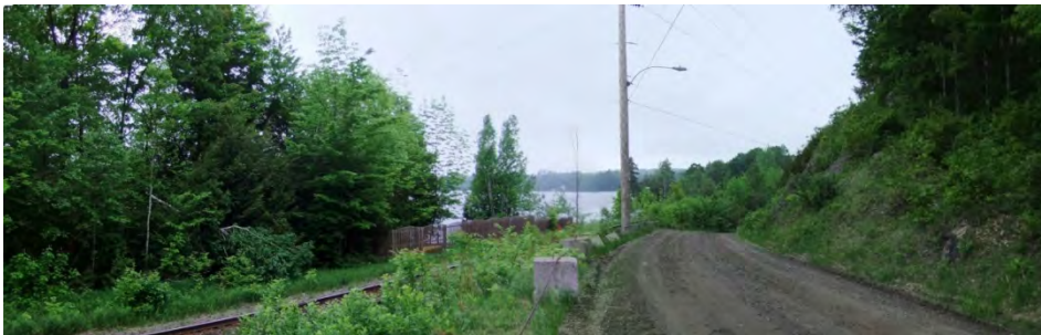
Image A1.07.03 : Assemblage de DSCF 1855.jpg à DSCF1857.jpg Deuxième section
