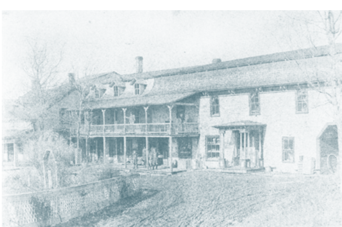
Résidence d'Aylmer Place, Millington, vers 1900. La famille Place habitait les trois étages de la section gauche du bâtiment alors qu'au rez-de-caussée de la partie droite, se trouvaient le bureau de poste et un magasin général. Une salle de danse occupait le deuxième étage.
