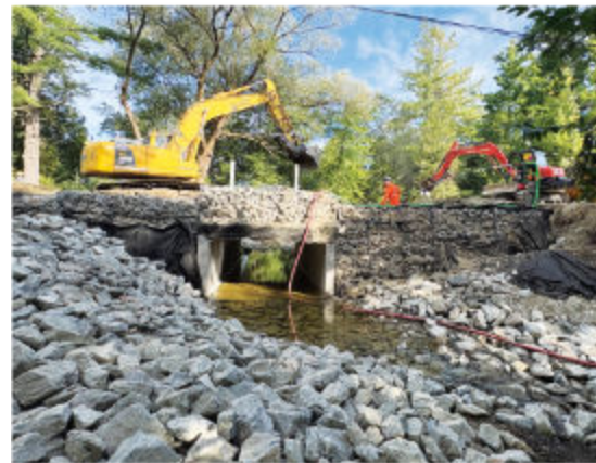
Ponceau installé sur le chemin North
