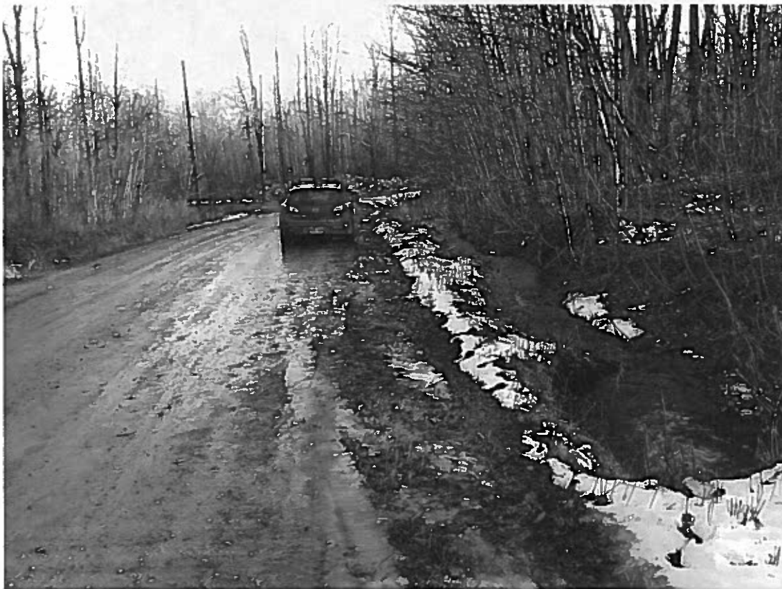
Figure 4 : Débit important dans un fossé (rue des Ormes)
