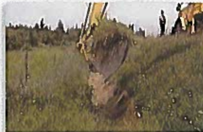
Excavation du fond du fossé à partir du talus opposé à la route, jusqu'à l'entaille.
