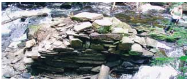
Vestiges de l'Old Beattie Dam. Emplacement de l'écluse destinée à réguler le débit de l'eau.
