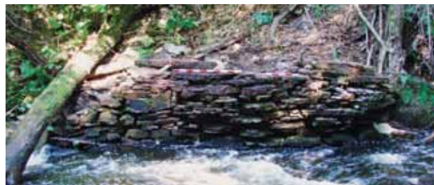
Mur de soutien du premier moulin Thompson, en rive droite.
